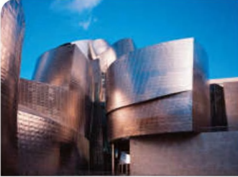
اختيرت ألواح التيتانيوم التي تغطي السطح الخارجي لمتحف غوغنهايم في بلباو، إسبانيا وفق الخصائص الفيزيائية للفلز.
