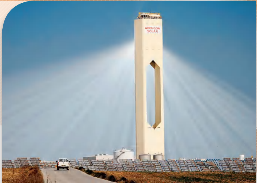
الشكل 11.1 منشأة الطاقة الشمسية Solúcar PS10 بالقرب من إشبيلية، إسبانيا. تعمل على تركيز الطاقة من الإشعاع الكهرومغناطيسي للشمس لإنتاج الكهرباء.
