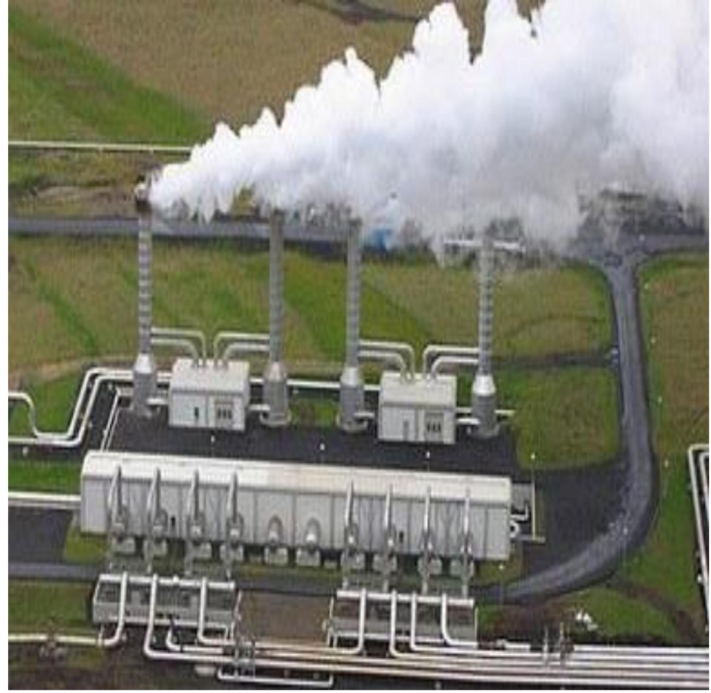
محطات البخار الجاف، لتوليد الكهرباء باستخدام "الطاقة الحرارية الجوفية"
